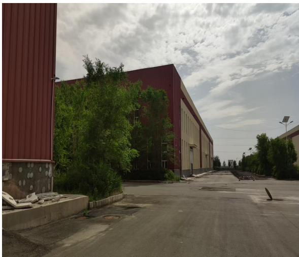
车间外西侧概况
