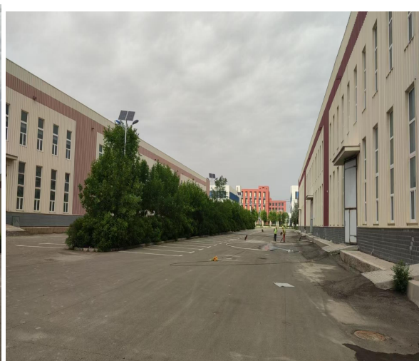
车间外北侧改造区域现状
