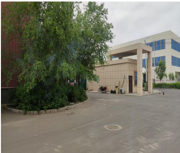
车间外东侧主要出入口概况
