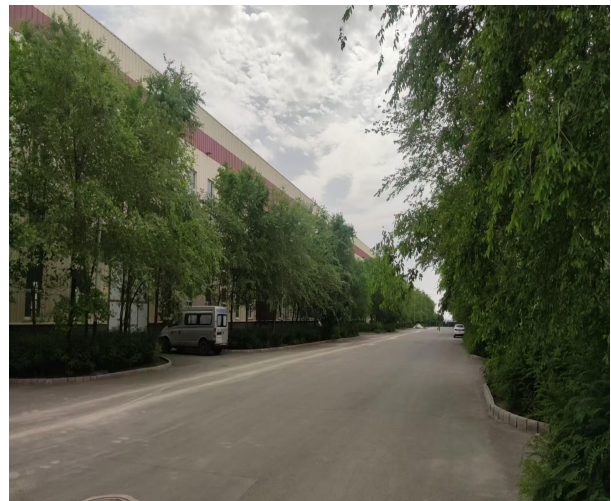
车间外南侧概况
